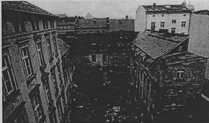
Blick auf den Hof der KW vor Renovierung. (Uwe Walter, 1997)
